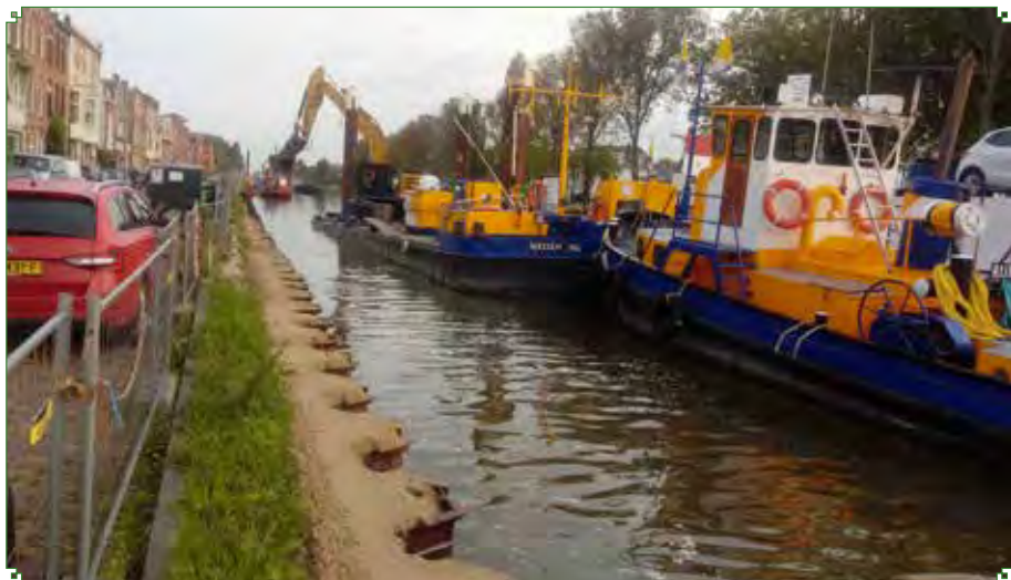
Oeverwerkzaamheden aan de kant van het Jaagpad
