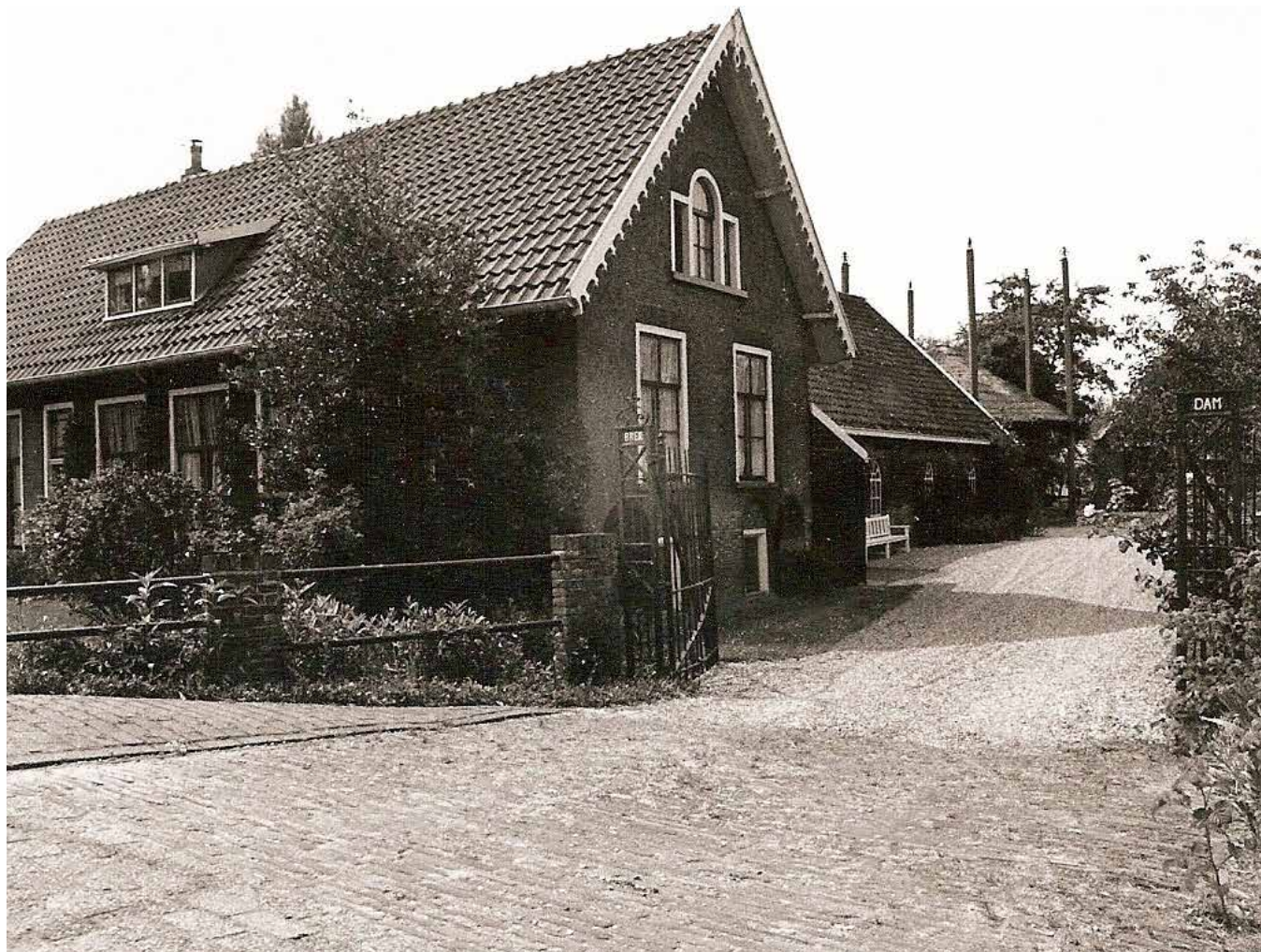
De boerderij nog in functie in 1989. (Foto: N. den Haan)
