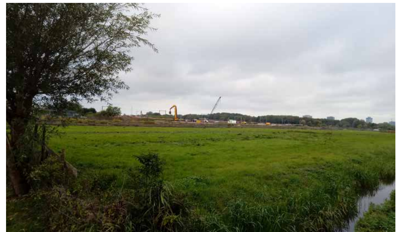
Begin van de werkzaamheden van de tunnel aan de oostzijde van de spoorlijn, vanaf 't Haantje. Op de achtergrond het Wilhelminapark (Foto: W. van Bijlert)
